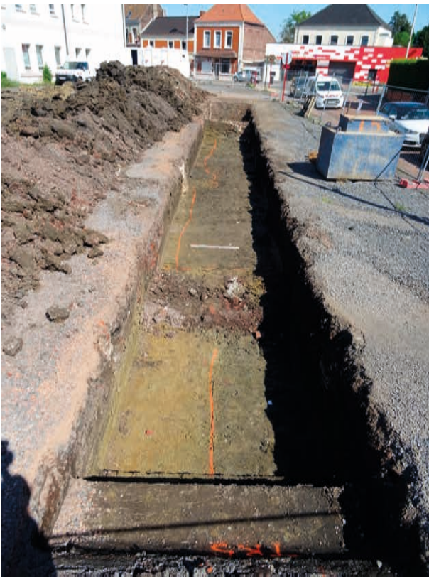
Fig.40 : tranchée 4, moitié septentrionale, depuis le sud. © Hervé Trawka, Ludovic Notte - Inrap.
