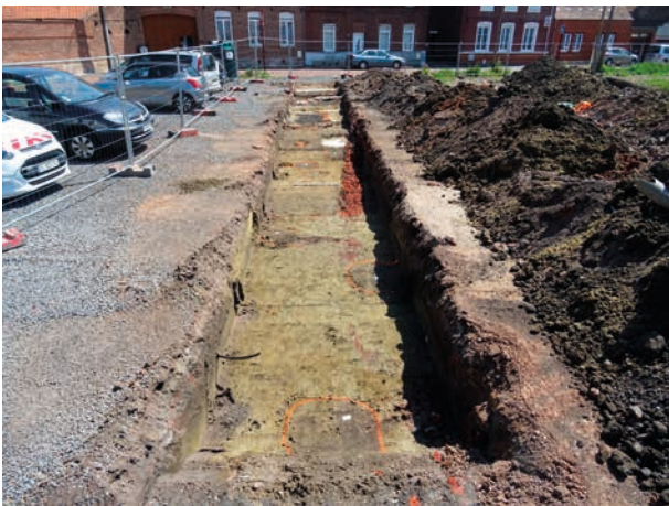
Fig.38 : tranchée 4, extrémité septentrionale, depuis le nord © Hervé Trawka, Ludovic Notte - Inrap.
