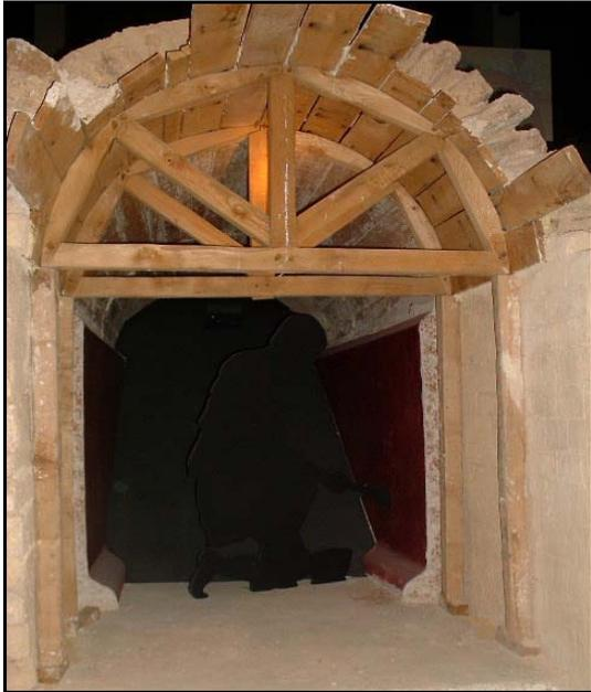
**Fig. 5 :** Méthode de construction d'une voûte avec le cintre posé sur des poteaux de bois, Musée du Pont du Gard [P. NEAUD, 2003].
