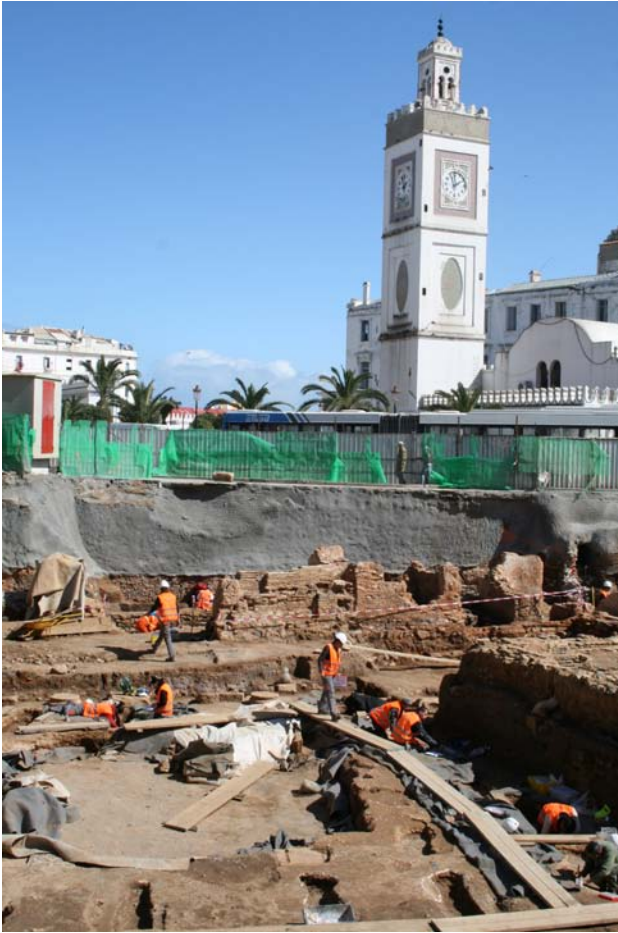
Fig. 2. Excavation site (Cécile Martinez, Inrap)
